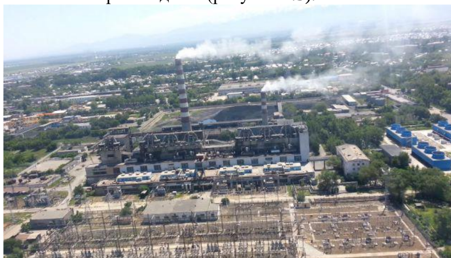
Рисунок 2.3 - Центральная часть ТЭЦ-3
